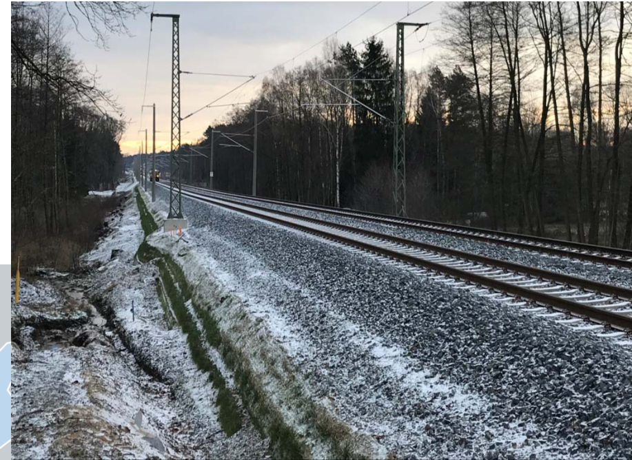
Strecke kurz vor Fertigstellung bei km 30,800
